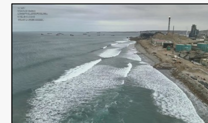
5/01/25 Monitoreo de condición de Terminal Submarino
